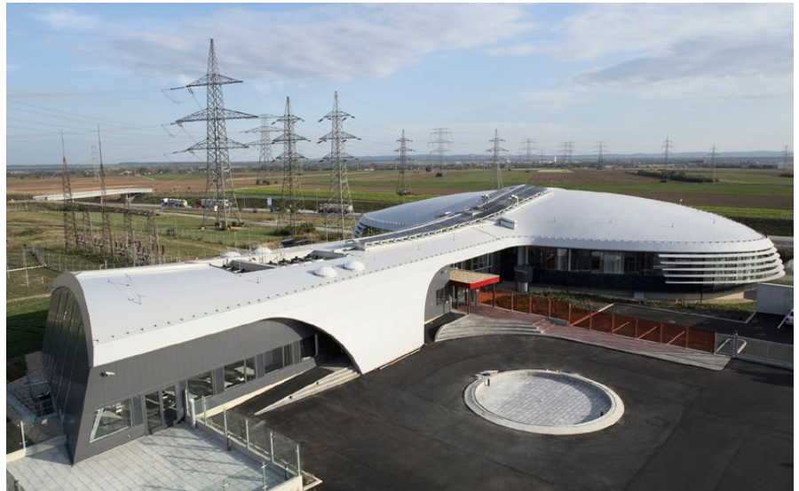
Die Power Grid Control wurde 2009 in Wien in Betrieb genommen. Sie ist das Nervenzentrum des österreichischen Übertragungsnetzes.
